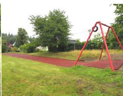
Fotos: Verlegung der Platten unter der Seilbahn im Außenbereich der Kinder- und Jugendhäuser „Future“ in
